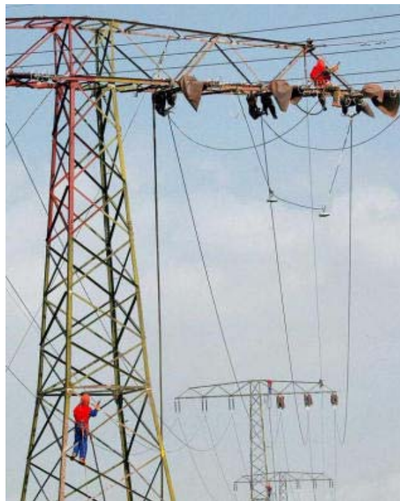
Líneas eléctricas de alta tensión
