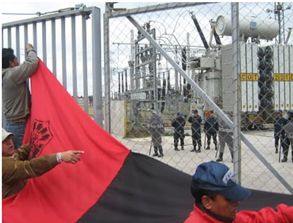
Electricistas de Toluca colocando banderas rojinegras simbólicas
