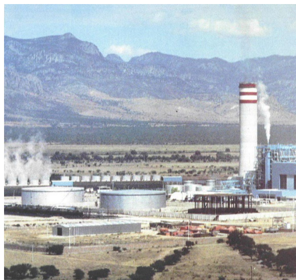
Central Termoelectrica San Luis Potosí.
