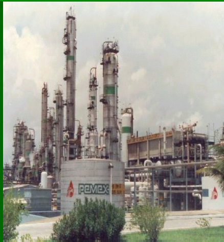
Instalaciones industriales de Pemex
