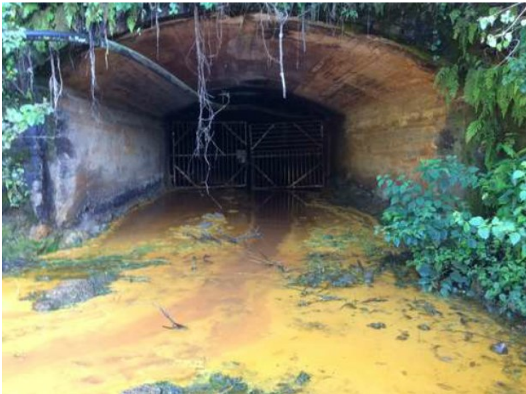
Contaminación en mina de Taxco, Grupo México. FOTO: S. Ocampo
