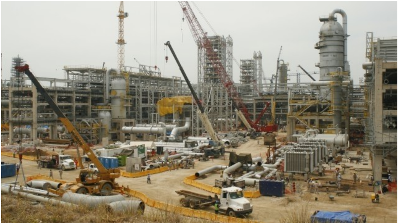
Planta Etileno XXI en Nanchital, Veracruz. El proyecto en construcción es Transnacional. Pemex ha renunciado a sus propios complejos petroquímicos, prefiere solo la exportación de petróleo crudo.
