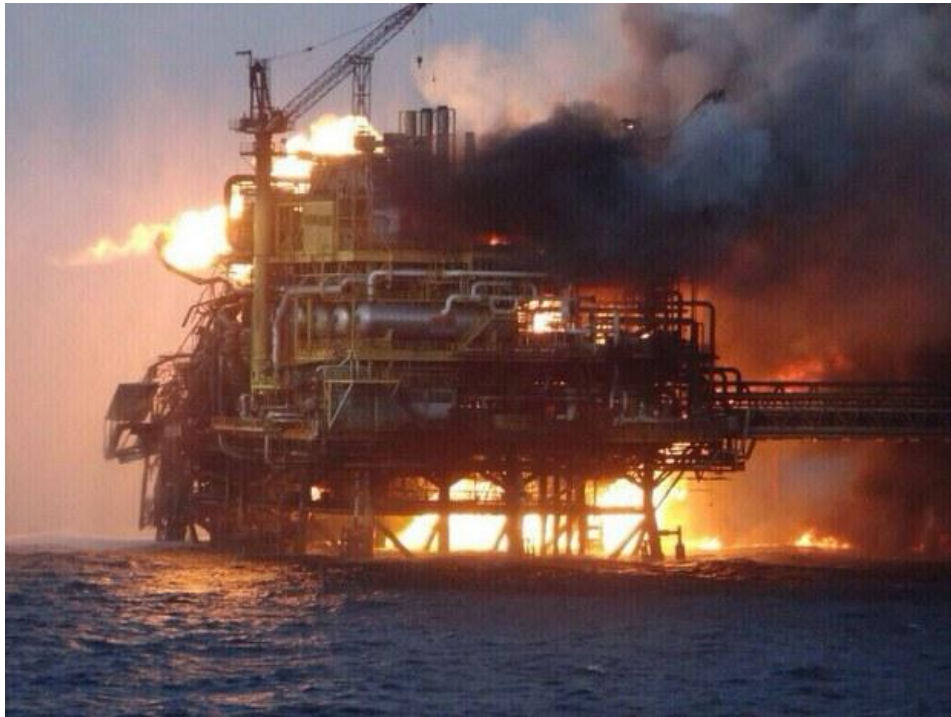
Incendio en la plataforma Abkatún A de Pemex. FOTO: La Jornada
