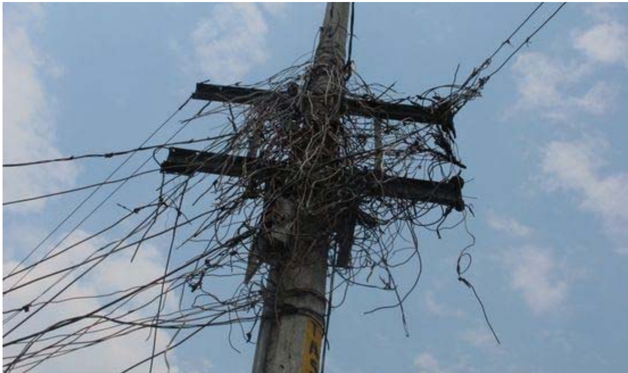
Para combatir las "pérdidas de energía", p.e. "diablos", se otorgó ya un contrato a Siemens
