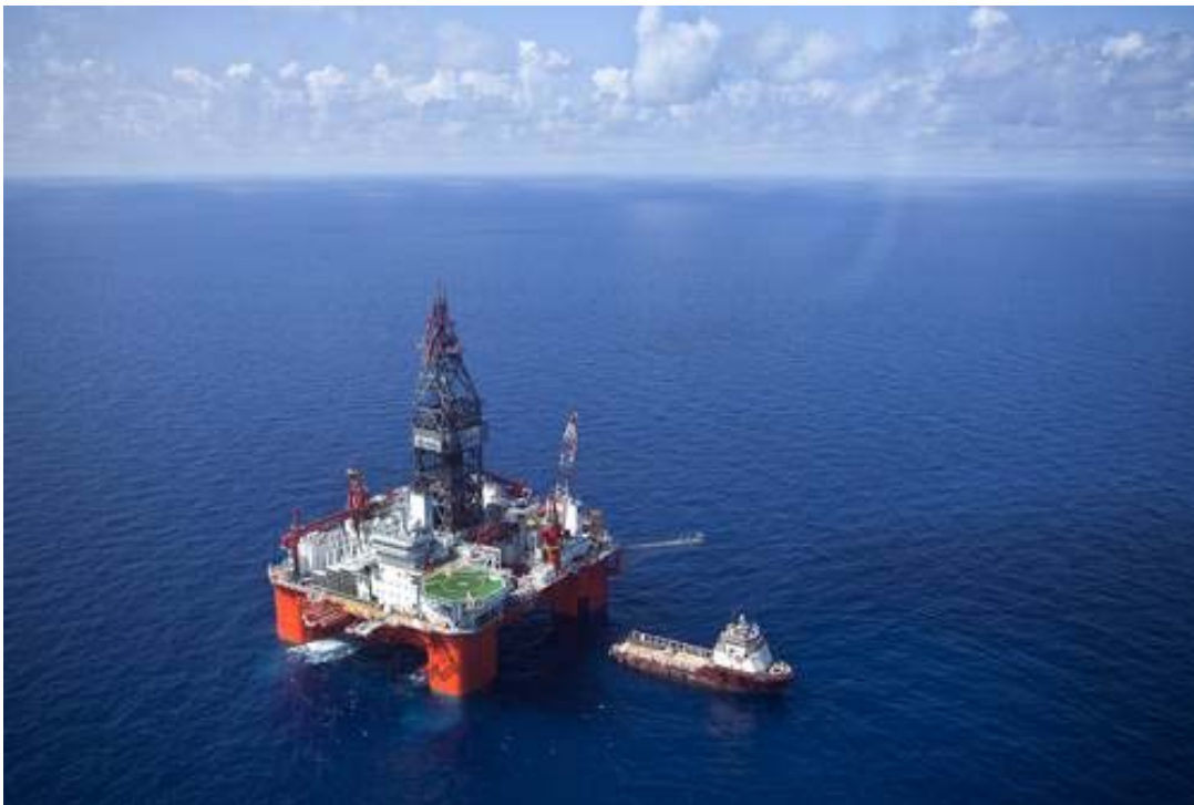
Plataforma petrolera privada Bicentenario en el pozo Talipao, Golfo de México
