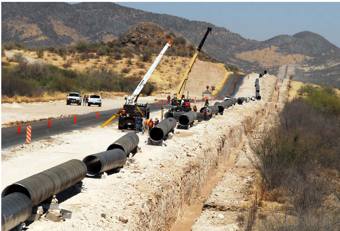
Acueducto Independencia, en Sonora FOTO: hermosillo.holahey.com
