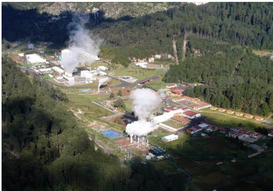
Campo geotérmico Los Azufres, Michoacán
