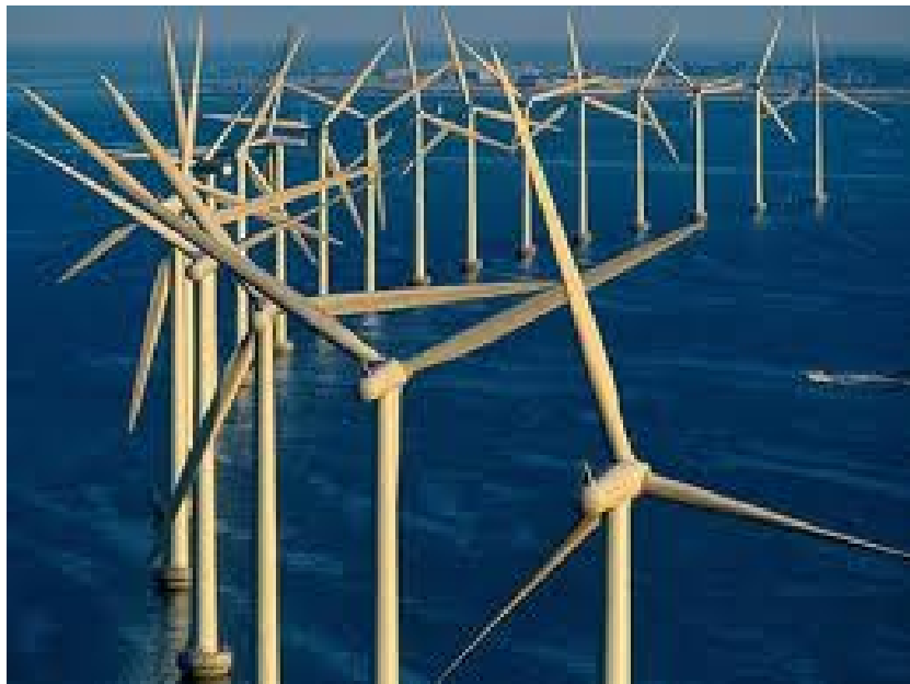
Aereadores desarrollados por Siemens.
