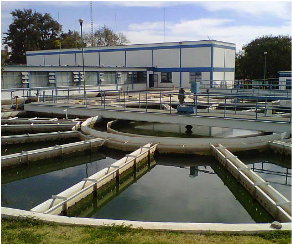
Sistema Intermunicipal de Agua Potable y Alcantarillado de Guadalajara
