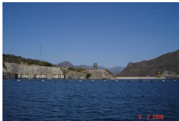
Central hidroeléctrica Chicoasén
