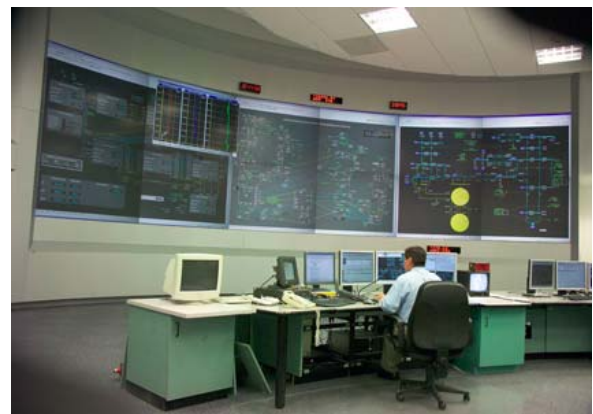
Centro Nacional de Control de Energía
