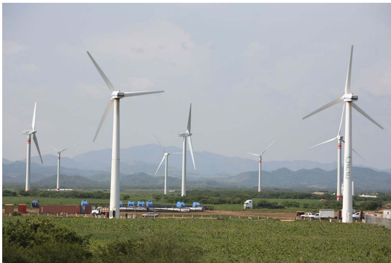
La eoloelectricidad es una fuente de energía renovable aprovechable pero solo por la industria eléctrica nacionalizada. Privatizada sirve para el negocio y el lucro, la fuente "limpia" se vuelve sucia
