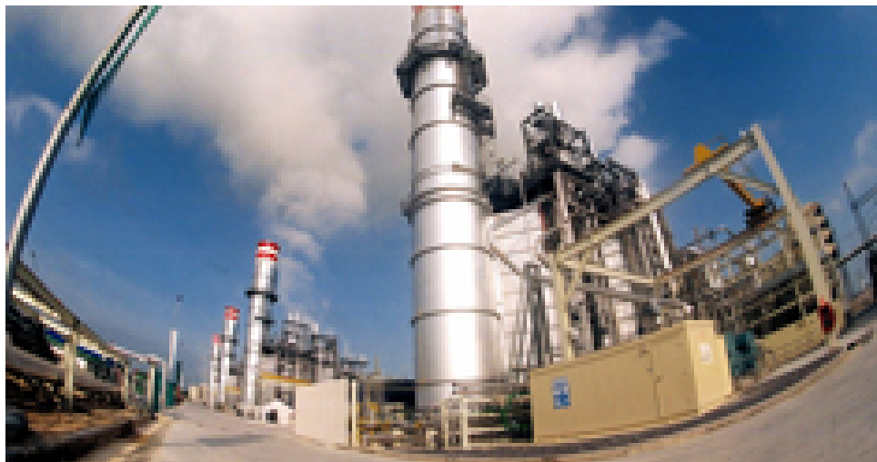
Central de ciclo combinado de Iberdrola Energía Monterrey, S.A. de C.V. Iberdrola de España opera una central de alta potencia, en la modalidad de FALSO autoabastecimiento, mediante un permiso privado de generación otorgado por la CRE
