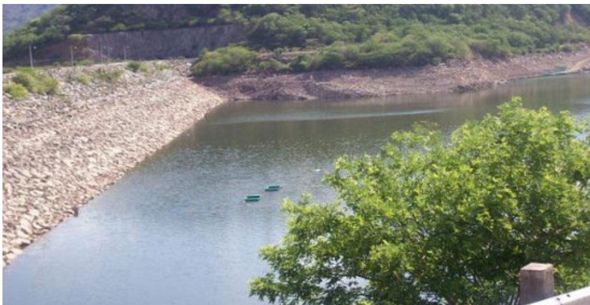
Presa El Gallo, en Cutzamala, Guerrero
