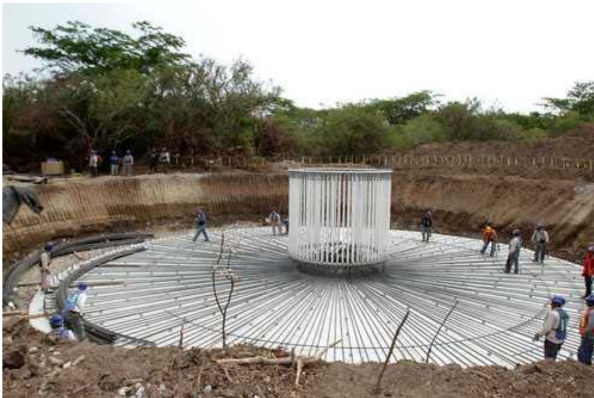
Base en construcción de un aerogenerador de Gas Natural Fenosa en Juchitán, Oaxaca. Peña y Videgaray quieren la privatización absoluta en materia energética FOTO: R. García
