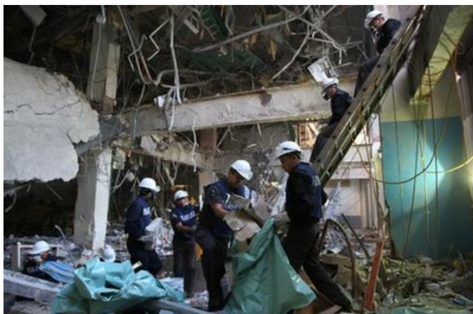
Destrucción en el sótano del edificio B2 de Pemex FOTO: F. Olvera
