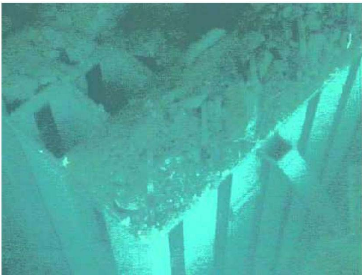
Racks de combustible dañado en una piscina de almacenamiento Fuente: OIEA
