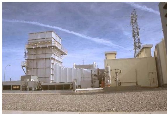
Central eléctrica privada Tuxpan de ciclo combinado. Las españolas Iberdrola y Gas Natural-Fenosa encabezan la privatización eléctrica furtiva del patrimonio colectivo de la nación.
