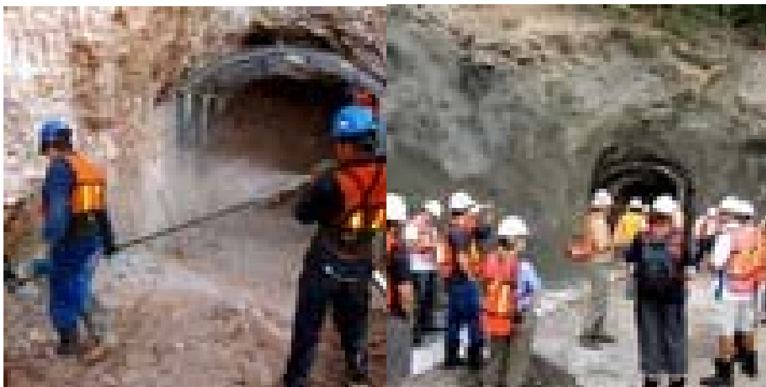
Perforación y túnel de la transnacional canadiense en Caballo Blanco FOTO: Golden Group
