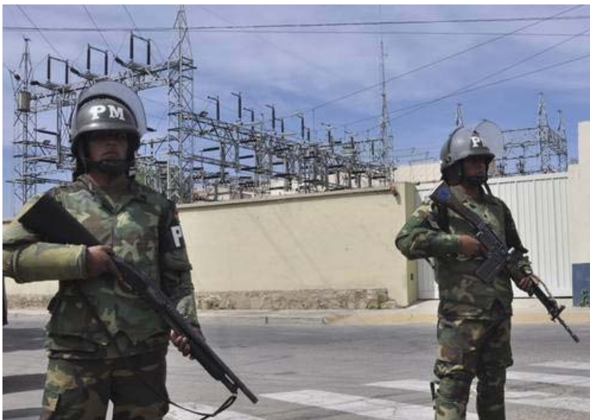
Empresa Transportadora de Electricidad, en Cochabamba, Bolivia, custodiada por soldados bolivianos FOTO: Ap.
