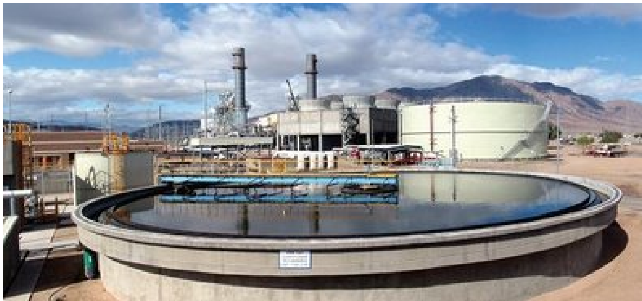
Central termoeléctrica de Mexicali. El 50% de la capacidad de generación eléctrica total a nivel nacional ya es privada en manos del capital transnacional. Eso, sigue sin decirle nada a las autollamadas "izquierdas". Para AMLO no existen siquiera las palabras "privatización furtiva"
