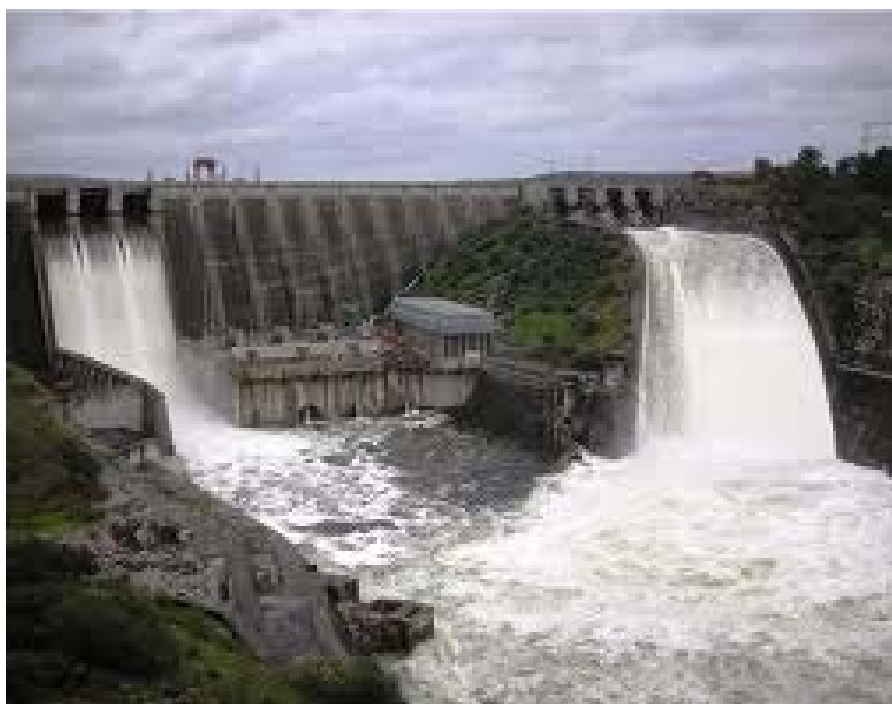
Central hidroeléctrica en Atexcaco, Puebla
