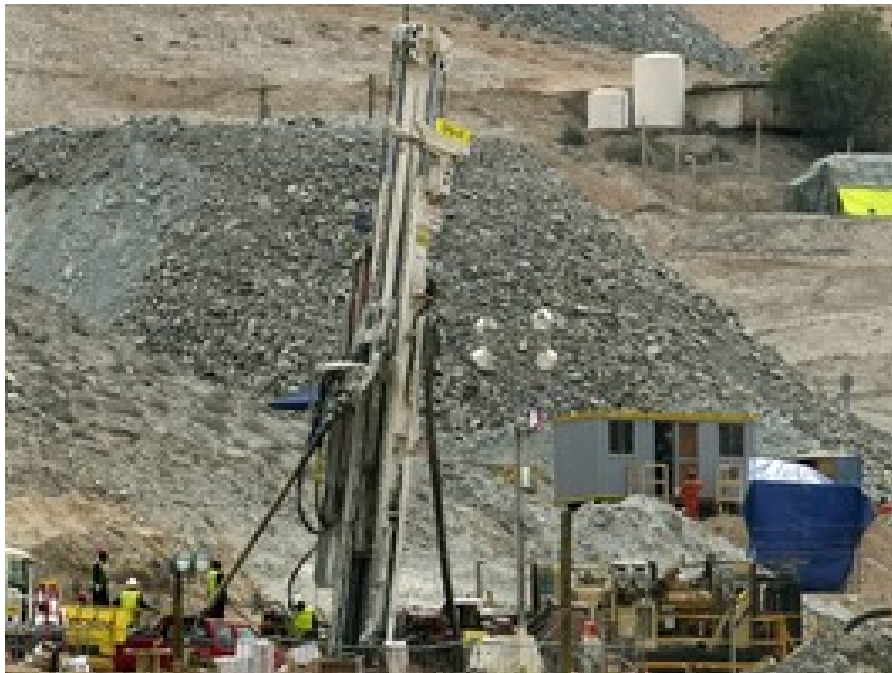
Construcción del túnel de acceso a la mina
