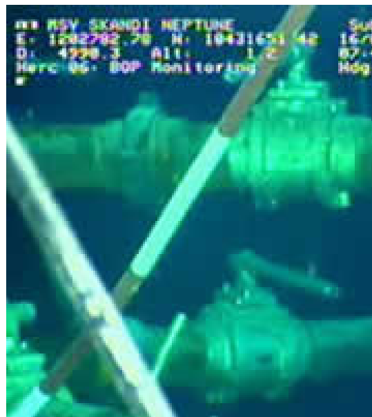
Válvulas en el pozo dañado
