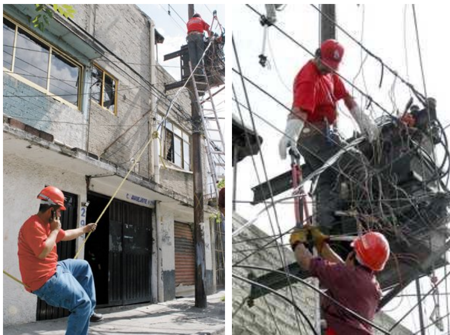
Contratistas eléctricos FOTOS: Cuarto Oscuro, V. Camacho
