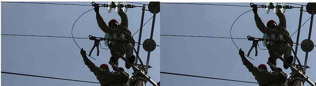
Electricistas, constructores de la industria eléctrica nacionalizada
