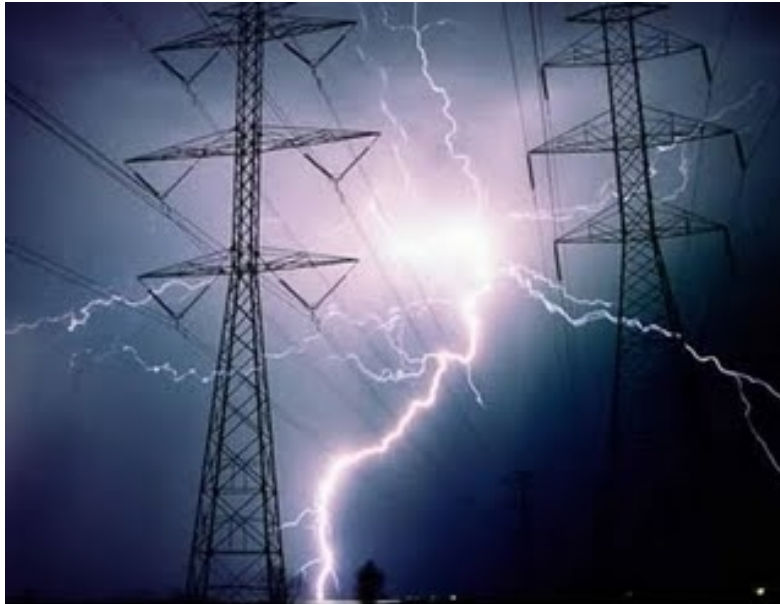
Redes del Sistema Eléctrico Nacional
