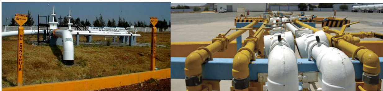
Parte del Sistema Nacional de Ductos de Petróleos Mexicanos
