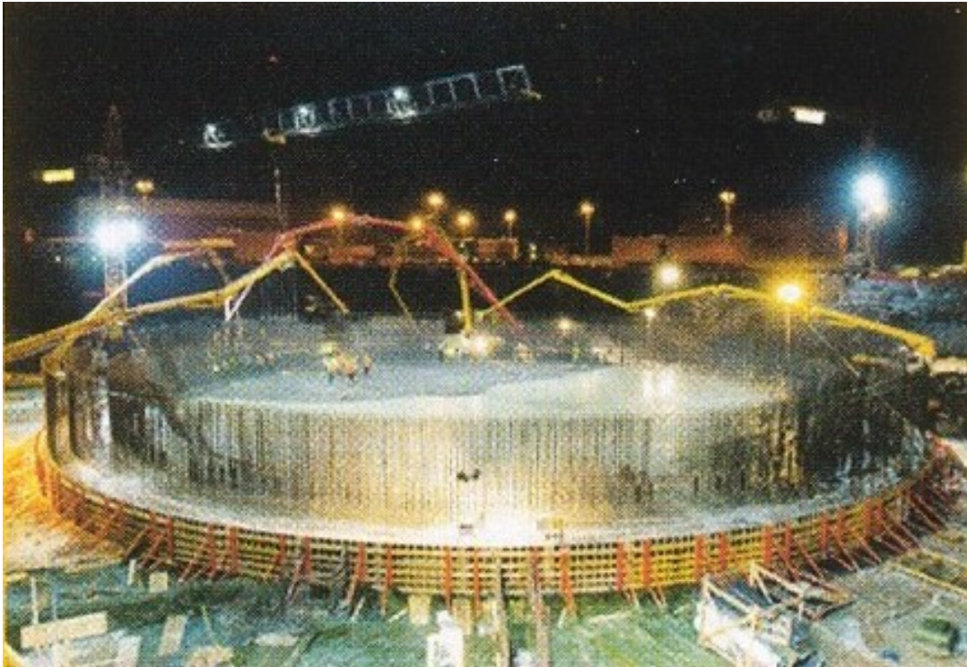
Central nuclear de Olkiluoto, Finlandia, Generación III+, 1,600 MWe
