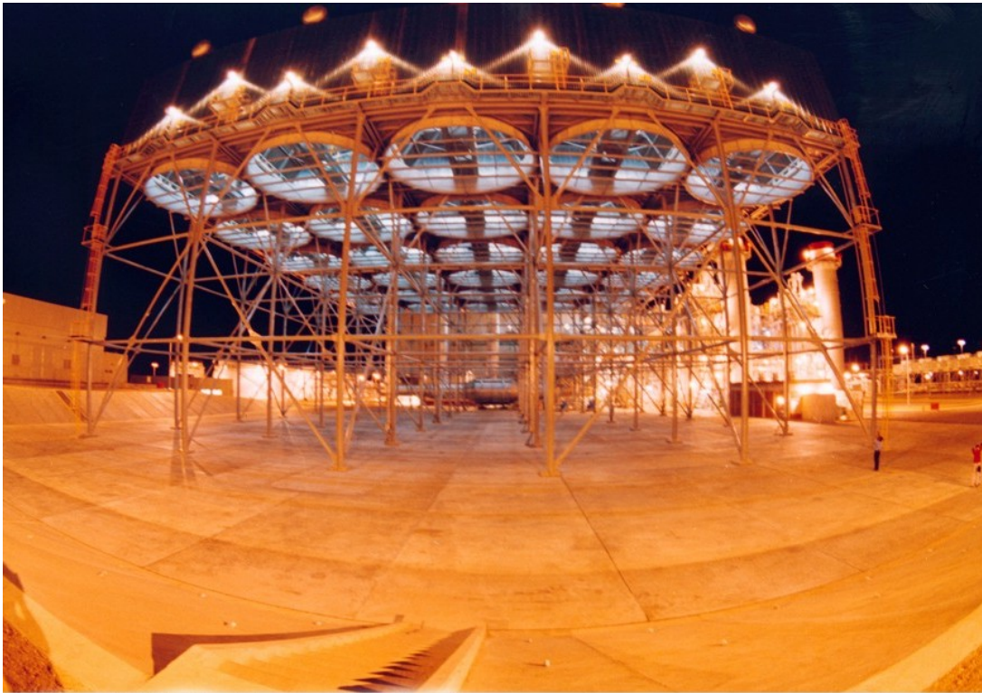
Central eléctrica de ciclo combinado a base de gas natural, Chihuahua II
