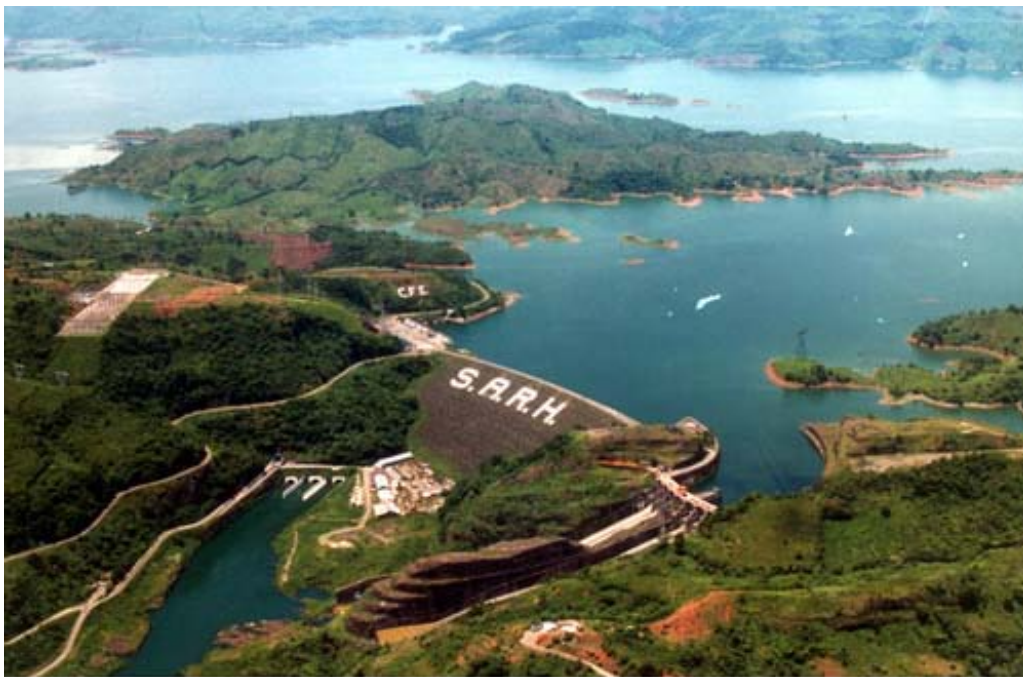
Central Hidroeléctrica Malpaso Chiapas, México
