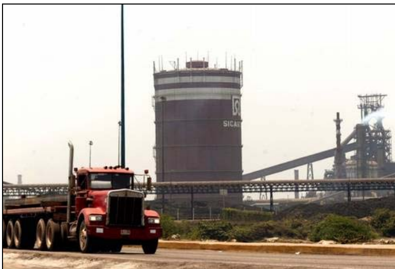
Instalaciones de la Siderúrgica Lázaro Cárdenas-Las Truchas, en el puerto del mismo nombre en las costas del Pacífico, la siderúrgica más importante de América Latina. FOTO: A. Domínguez.
