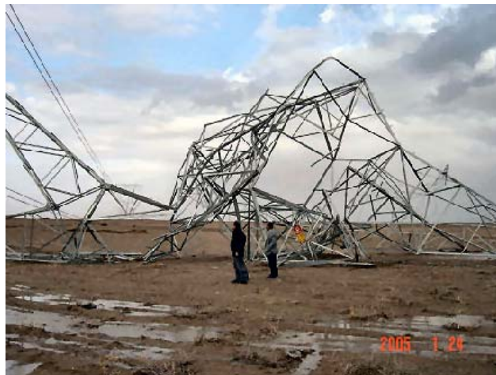
Torre de transmisión eléctrica derribada por la resistencia.
