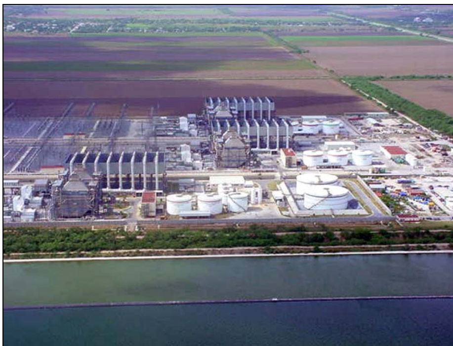
Central termoeléctrica de ciclo combinado Río Bravo III, en Tamaulipas, propiedad privada de la transnacional Electricité de France.
