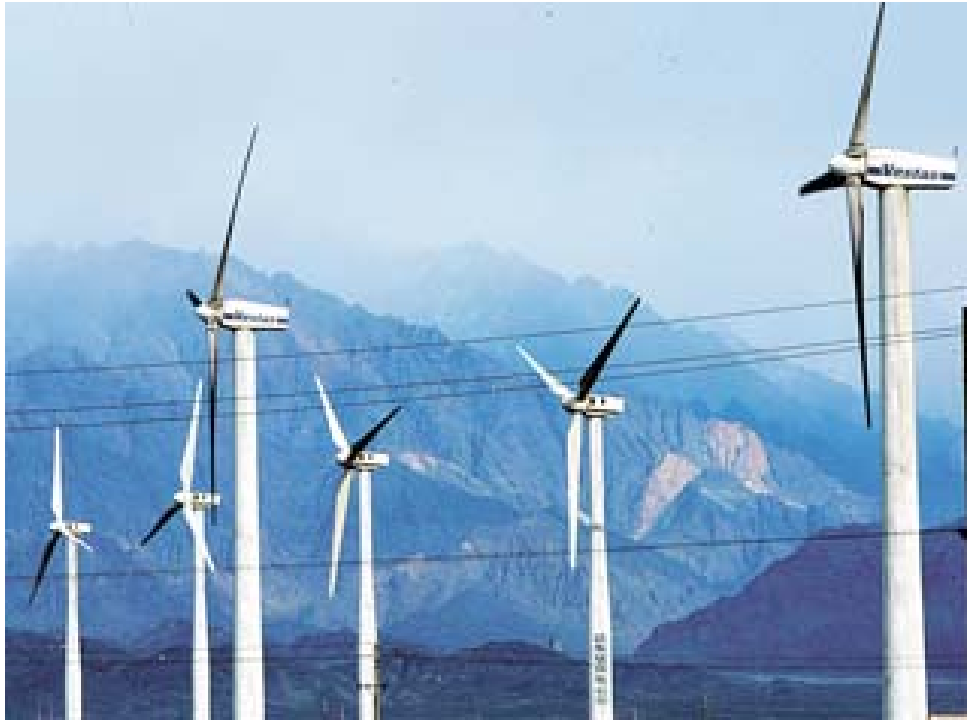
Aerogeneradores privados en Tehuantepec, Oaxaca
