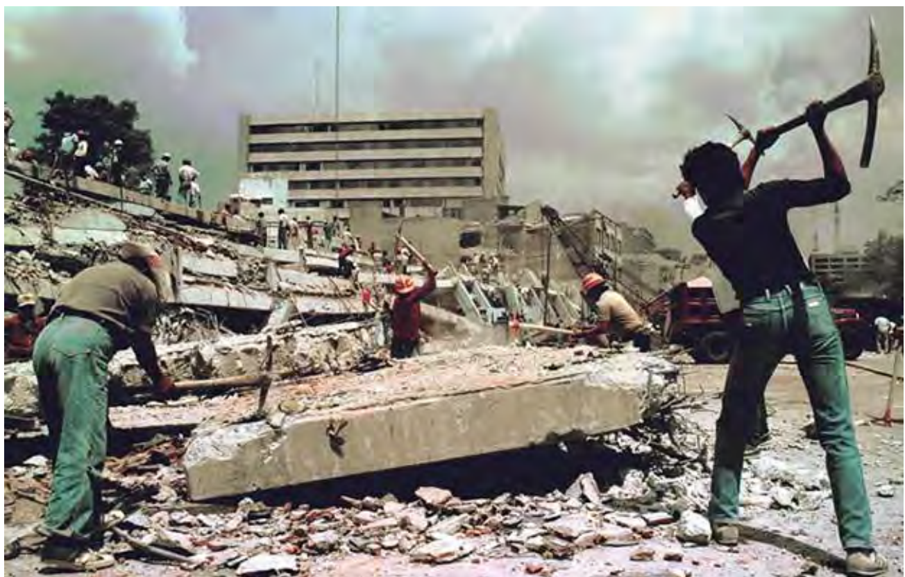
Remoción de escombros en el Hospital de Pediatría. FOTO: Cuartoscuro
