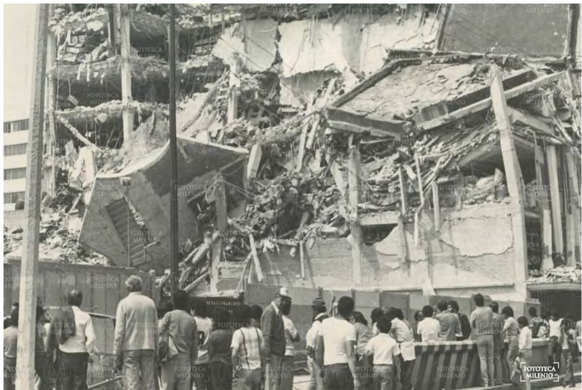
Edificio afectado en Artículo 123 y Eje central. FOTO: Milenio
