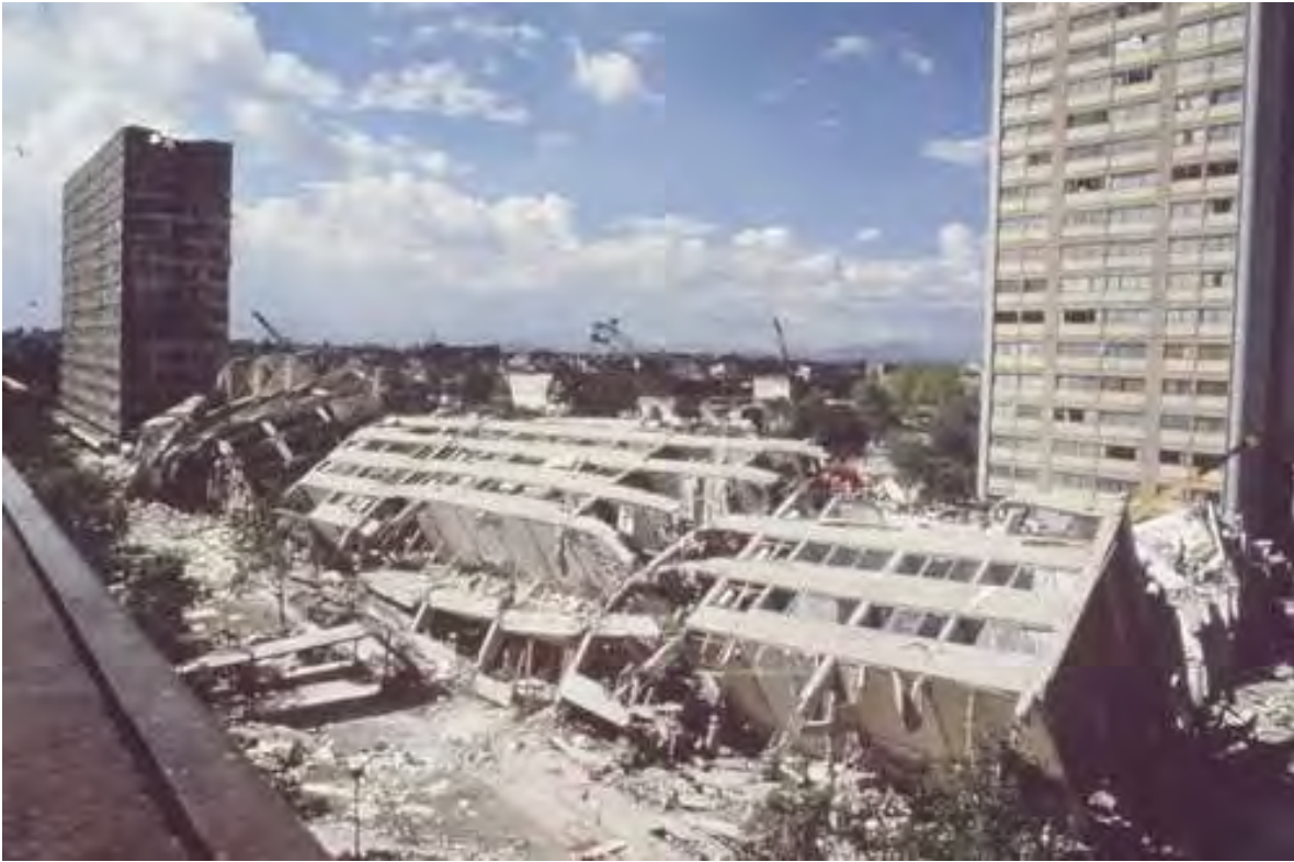
Derrumbe del edificio Nuevo León, en Tlatelolco. FOTO: J. Villaseca
