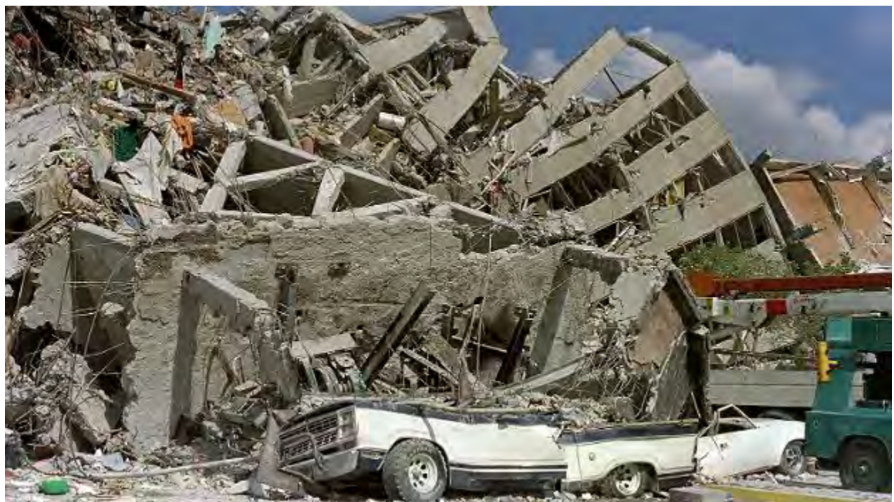
Edificios enteros cayeron debido al terremoto. FOTO: bbc.com
