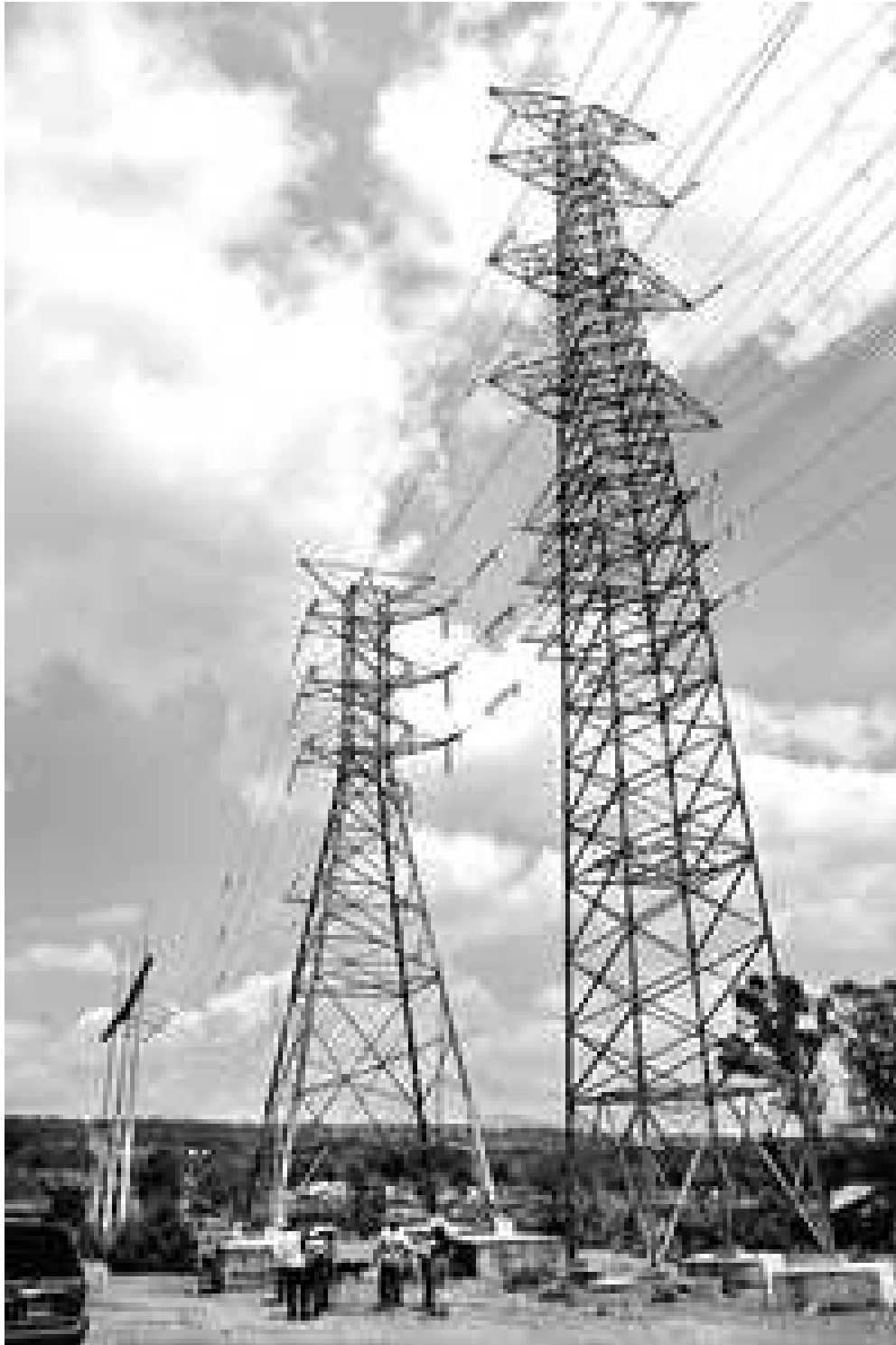
Torres de transmisión eléctrica en Tulancingo, Hidalgo. El 63.66% de la generación eléctrica total a nivel nacional ya es privada, siguen la transmisión y distribución eléctrica FOTO: V. Camacho
