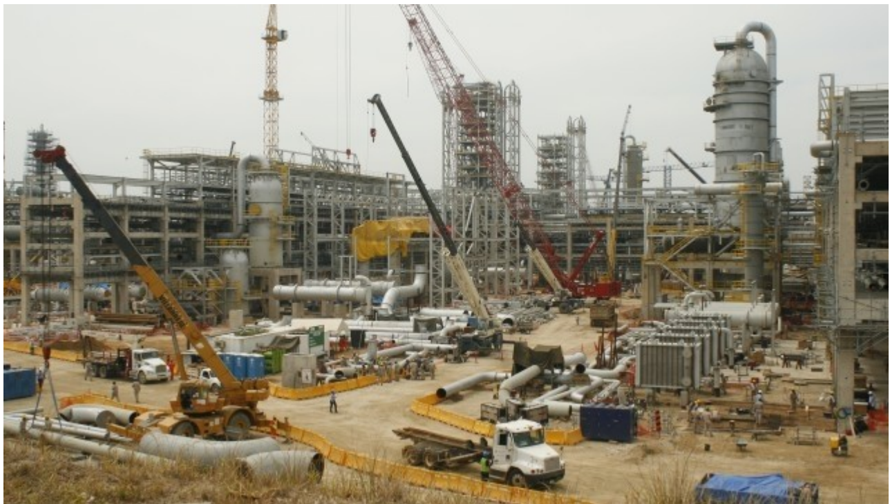
Planta Etileno XXI en Nanchital, Veracruz. El proyecto en construcción es Transnacional. Pemex ha renunciado a sus propios complejos petroquímicos, prefiere solo la exportación de petróleo crudo.
