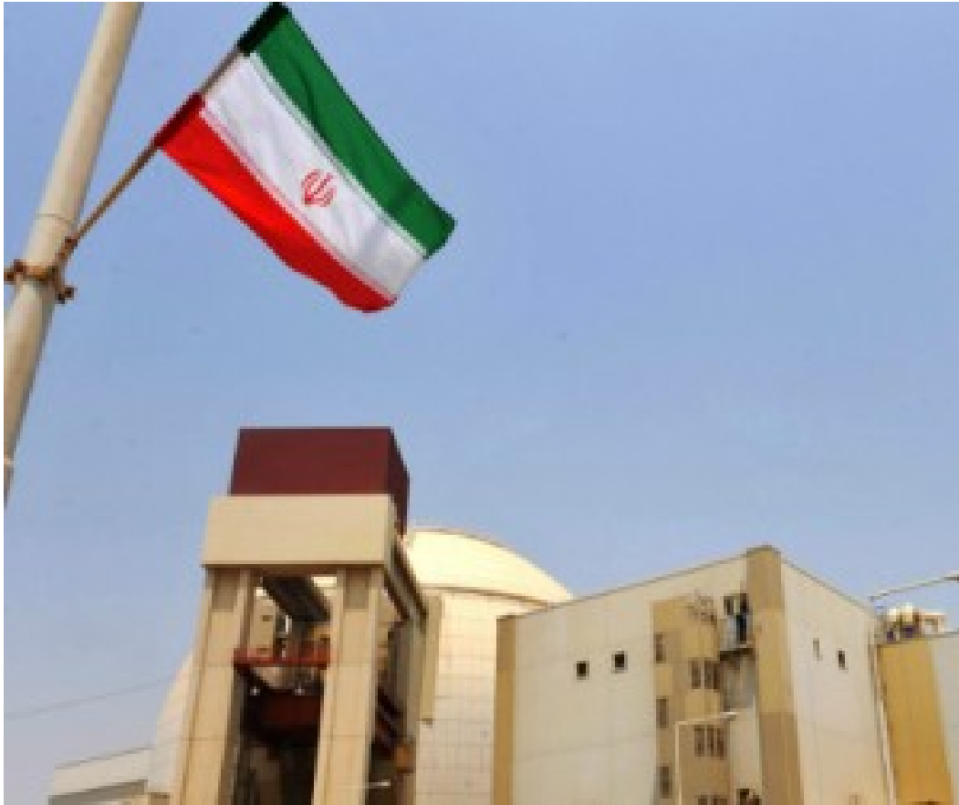
Central Nucleoeléctrica Bushehr, de Irán, con 1,000 MWe de potencia
