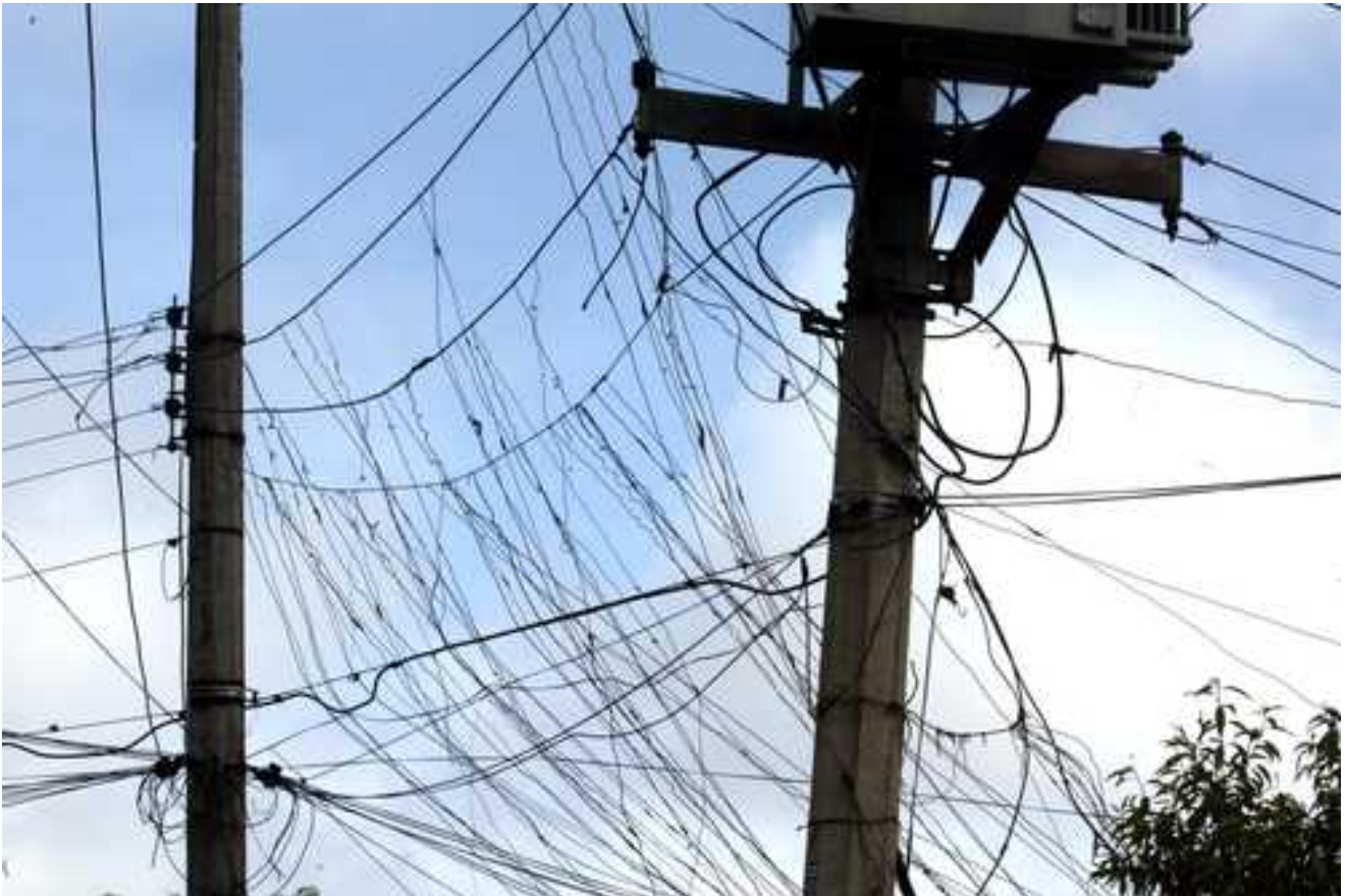
Cables en Cuajimalpa. El desbarajuste está generalizándose al realizar la CFE todas sus obras de expansión mediante contratistas privados. FOTO: M. L. Severiano
