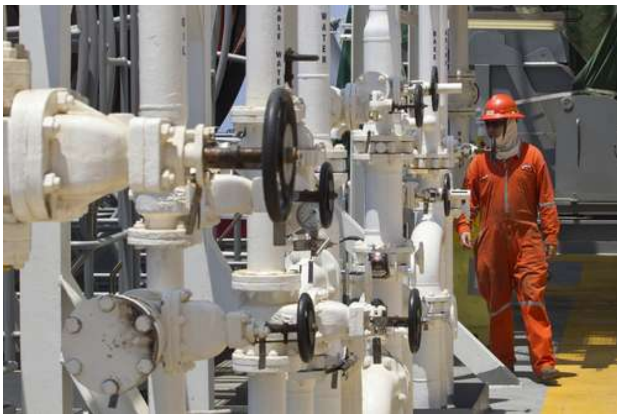
Plataforma Bicentenario, pozo Talipao, Golfo de México. FOTO: J. C. González
