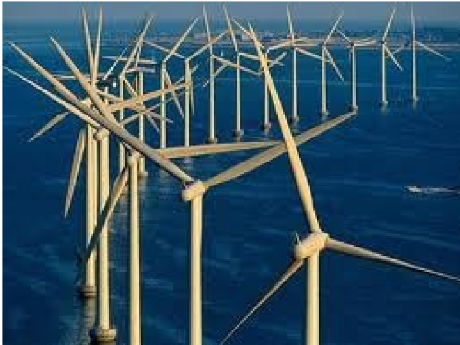
Aereadores desarrollados por Siemens.
