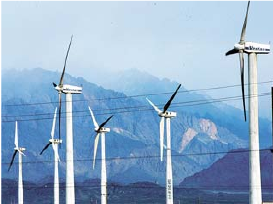
Aerogeneradores privados en Tehuantepec, Oaxaca
