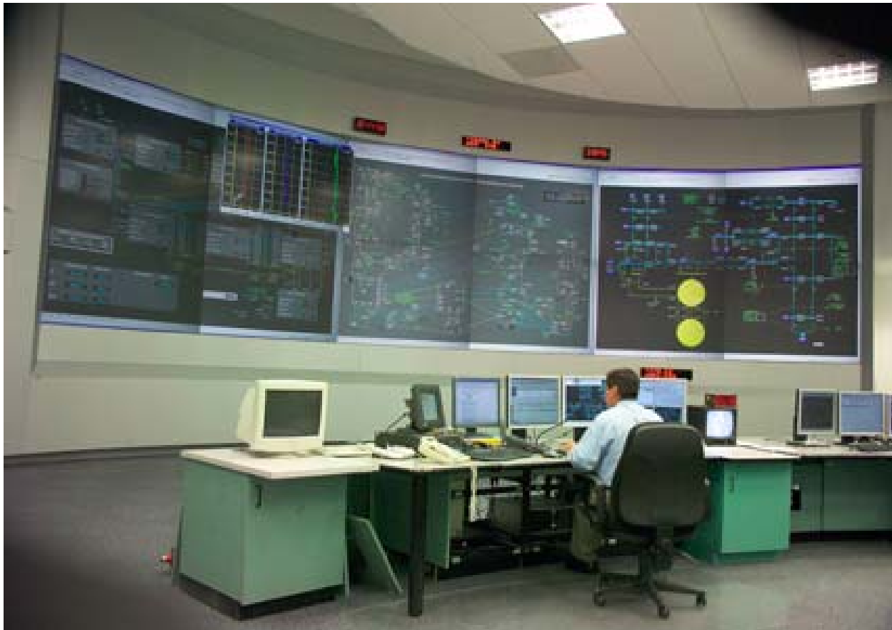
Centro Nacional de Control de Energía
