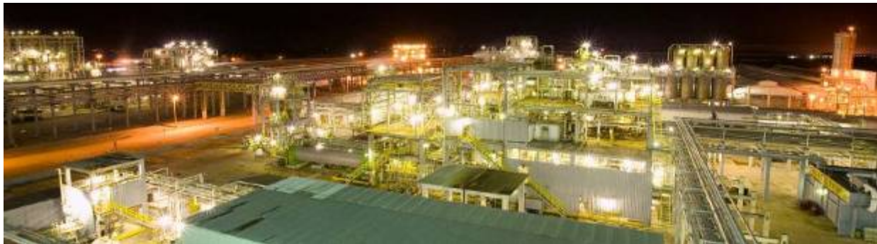
Complejo petroquímico Morelos, de Pemex. Todo será privatizado: exploración, producción y refinación de petróleo, procesamiento, distribución y transporte de gas, y absolutamente toda la petroquímica
