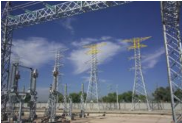
Destruir el Sistema Eléctrico Nacional que jamás construyó y privatizarlo entregándolo a las transnacionales, propuesta de Elías Ayub
