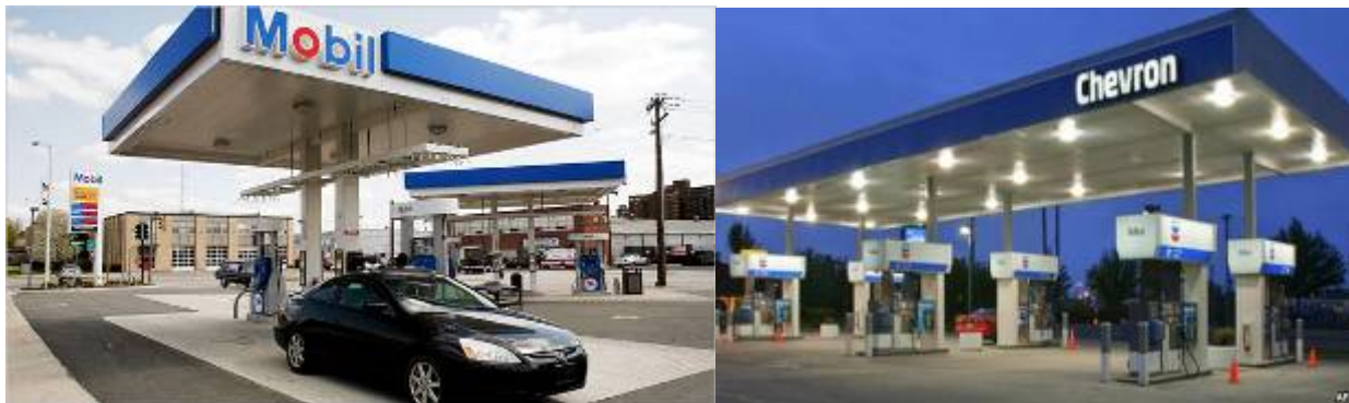
Gasolineras automatizadas de Mobil y Chevron
