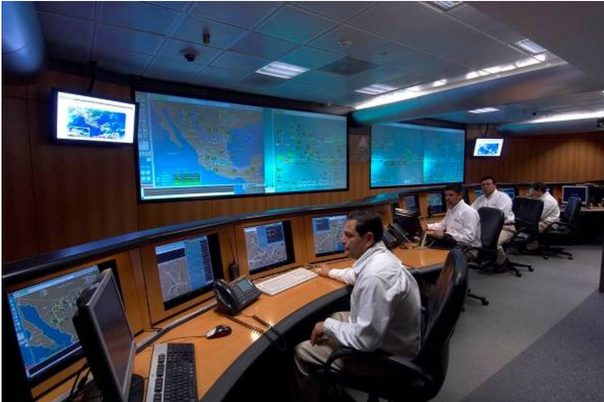
Centro de control del sistema Scada
