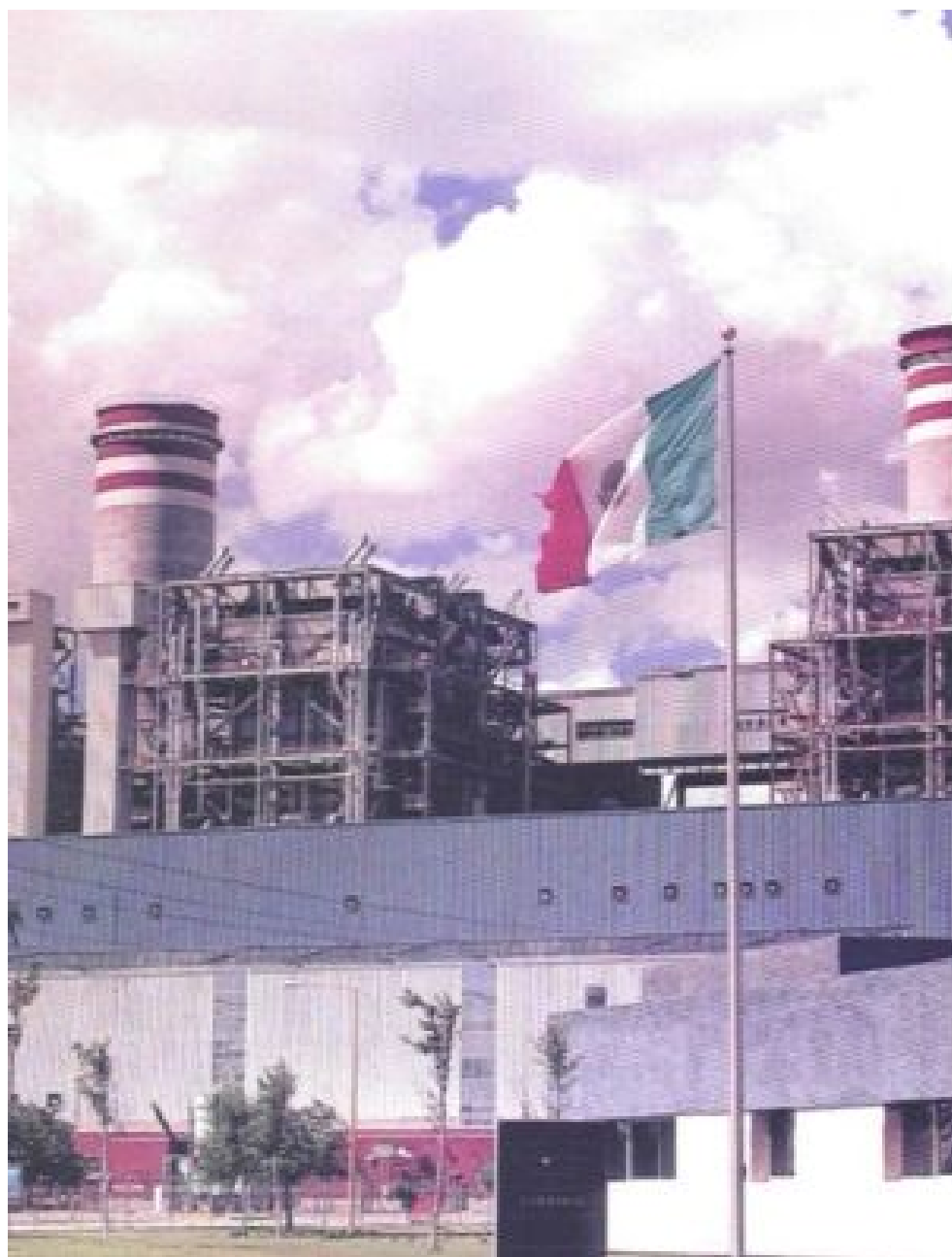
Central termoeléctrica de la industria eléctrica nacionalizada
